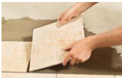
Lepljenje keramičnih ploščic
