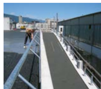
Parkirne garaže uključujući prilazne putove
