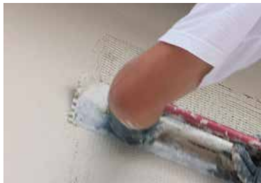
Umetanje grube staklene mrežice za armiranje
