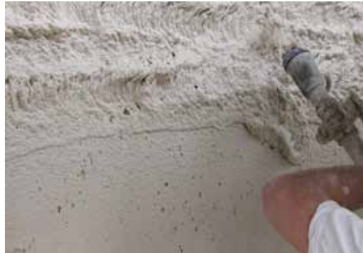
Nanošenje izolacijske žbuke
