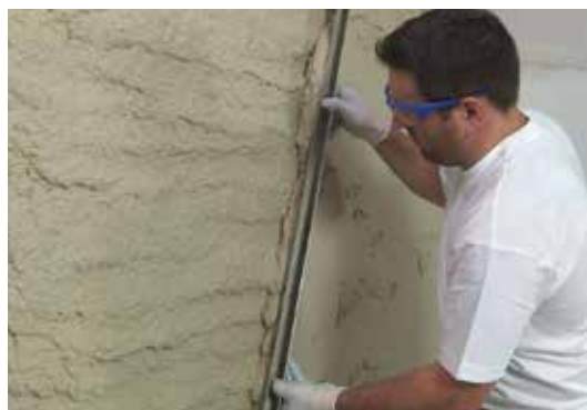
Izravnavanje izolacijske žbuke
