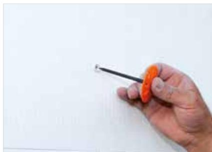
Den Faserverbundnagel mit dem BTH-Befestigungsteller in den DüBELschaft einführen.
