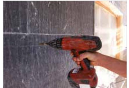
Dübellöcher mit einem in einer Bohrmaschine eingespannten Körner in einem Raster von 40x40 cm vorlochen, um ein Aufwickeln der Fasern beim Bohren zu vermeiden.
