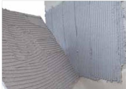
Der Kleber auf den Dämmplatten in der Gegenrichtung durchkämmen. Dämmplatten im Buttering- Floatingverfahren einschwenken.
