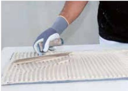
Auftrag von AeroCalce® IA 780 COLL auf dem Mauerwerksuntergrund und auf der Dämmmatte (buttering & floating) und durchkämmen des Auftrags mit der Zahntraufel.
