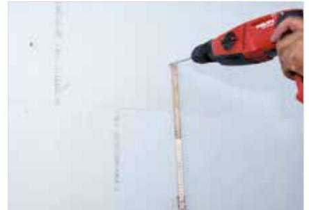
Die Bohrlöcher werden mit einem 8 mm Bohrer in einem 40x40 cm Raster erstellt.
