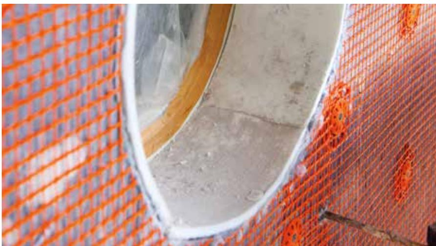
Die RÖFIX IB 015 Aerogel Dämmplatte mit Beschichtung kann kleinflächig mit RÖFIX AeroCalce oder mit anderen Wärmedämm-Systemen perfekt kombiniert werden. „Bewegte“ Oberflächen können 1:1 übernommen werden.
