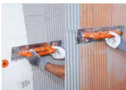
Die gedämmte Oberfläche wird nun mit RÖFIX Unistar® LIGHT mit einer Nennputzdicke von 5 mm verputzt. Im äusseren Drittel der Armierschicht wird das RÖFIX P50 Armierungsgewebe eingebettet (bei den Stössen der Gewerbehahnen 10 cm überlappen).
