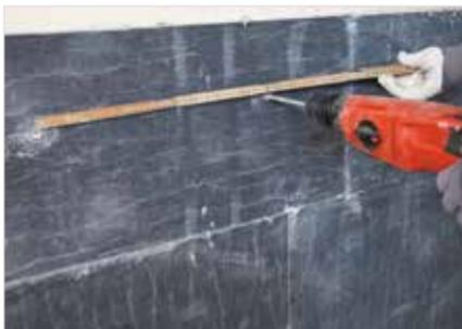
Das Bohrloch wird mit einem 8 mm Bohrer erstellt.
