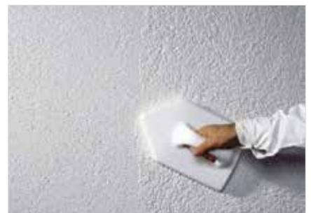
Wenn der armierte Unterputz trocken ist, kann der RÖFIX Oberputz aufgetragen und nach Wunsch strukturiert werden. Nach der Trocknung des Oberputzes kann dieser mit einer systemkonformen RÖFIX Innenfarbe gestrichen werden.
