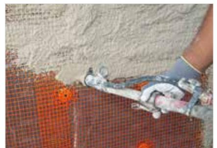
Das vormontierte Stützgewebe wird mit RÖFIX AeroCalce® IA 782 THERMO Hydraulikalk-Wärmedämmputz 30 mm stark oder mit RÖFIX AeroCalce® IA 784 PLUS 10 mm dick überputzt.
