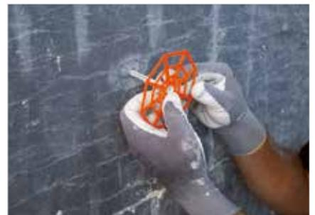
Das AeroCalce® IF 980 Befestigungsset wird bis zum Anschlag in das Bohrloch eingeschoben.
