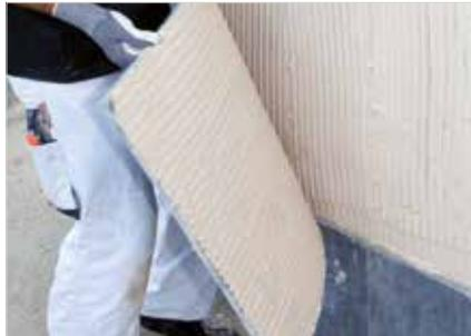
Erste und folgende Lagen der AeroCalce® IB 980 im frischen vollflächig aufgetragenen Kleber einschwimmen und die Fugen mörtelfrei satt aneinanderstossen.
