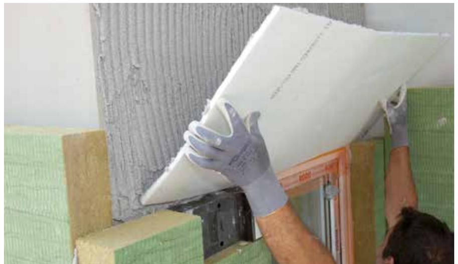
Die RÖFIX IB 015 Aerogel Dämmplatte mit Beschichtung eignet sich durch die einfache Anwendung bestens z.B. als Wärmebrückenlöser unter Schürzelementen, und als Problemlöser in vielen anderen Fällen, wo normal durch Platzmangel keine Dämmung möglich wäre.
