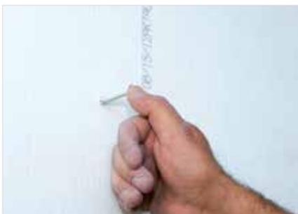
DüBELschaft bündig zur Dämmplattenoberfläche einschieben.
