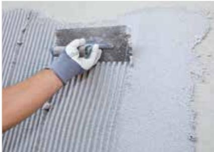
Maschineller oder händischer Auftrag von RÖFIX Unistar® LIGHT auf den tragfähigen Untergrund und auf die Dämmplatten. Anschliessend mit der Zahntraufel (ca. 6x6 mm) durchkämmen.
