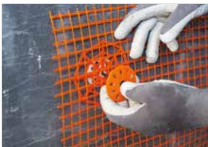
Auflegen des AeroCalce® IG 980 AR-Stützgewebes und Zusammensetzung des zweiten Teiles des Befestigungssets.
