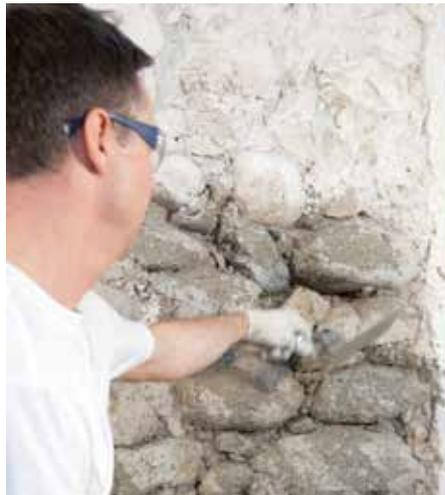
Anwurf mit RÖFIX 671 Sanier-Vorspritzmörtel, 60% deckend
