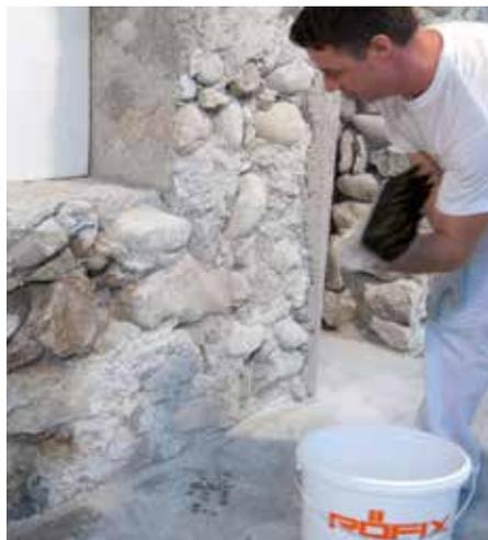
Anwurf RÖFIX Saniergrund mittels Malerbürste
