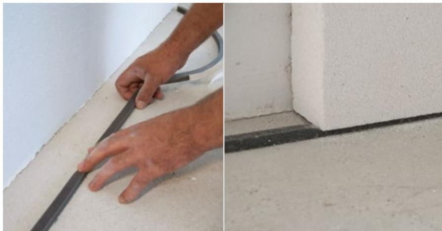
Chiudere con RÖFIX Nastro di guarnizione il sistemi isolante per interni contro il pavimento, la parete ed il soffitto.
