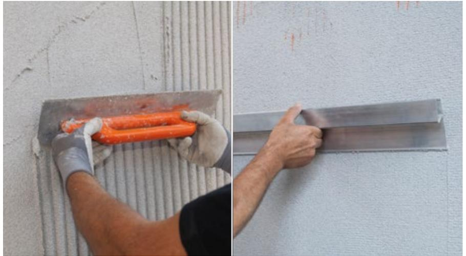
Stendere il rasante e distribuirlo con cordoli verticali uniformi e annegare la rete di armatura RÖFIX P50. Con la spatola liscia è possibile tirare una superficie planare.
