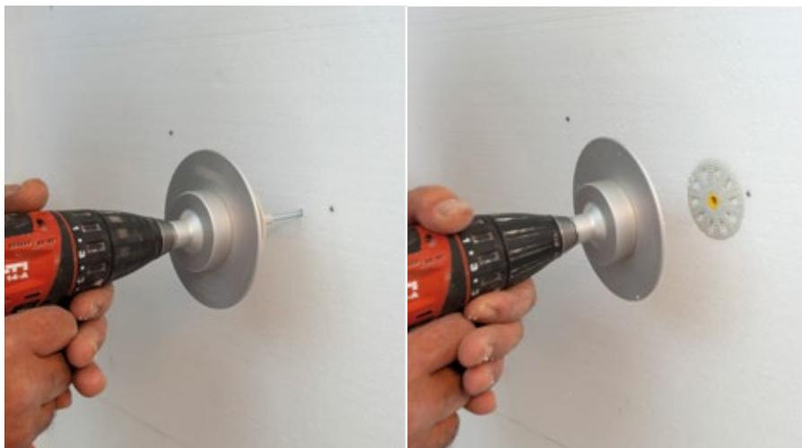
RÖFIX ROCKET WOOD può anche essere montato a filo o anche ad incasso su pannelli in EPS e lana di roccia
