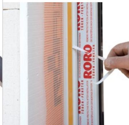
Incollare RÖFIX MINI 3D sul telaio della finestra e proteggere la finestra prima della rasatura
