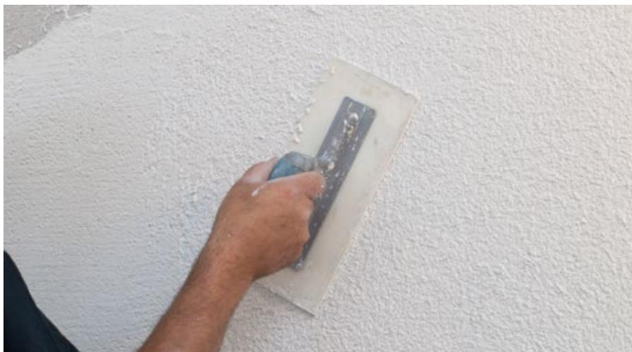
Strutturare il rivestimento murale in funzione della tipologia di rivestimento e della struttura finale desiderata.
