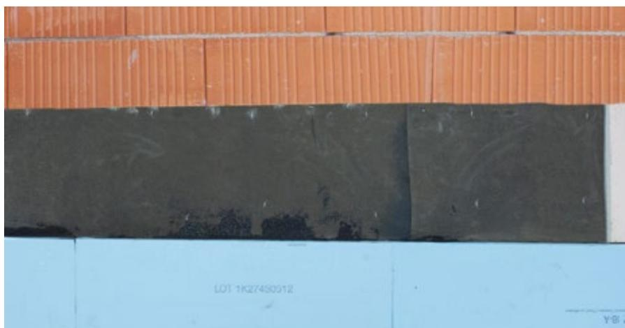
Pannelli isolanti perimetrali incollati con collante bituminoso o specifico collante impermeabilizzante (RÖFIX OPTIFLEX® o RÖFIX Collstar)
