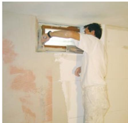
Montaggio con RÖFIX Renopor® Accessorio cuneiforme per soffitti
