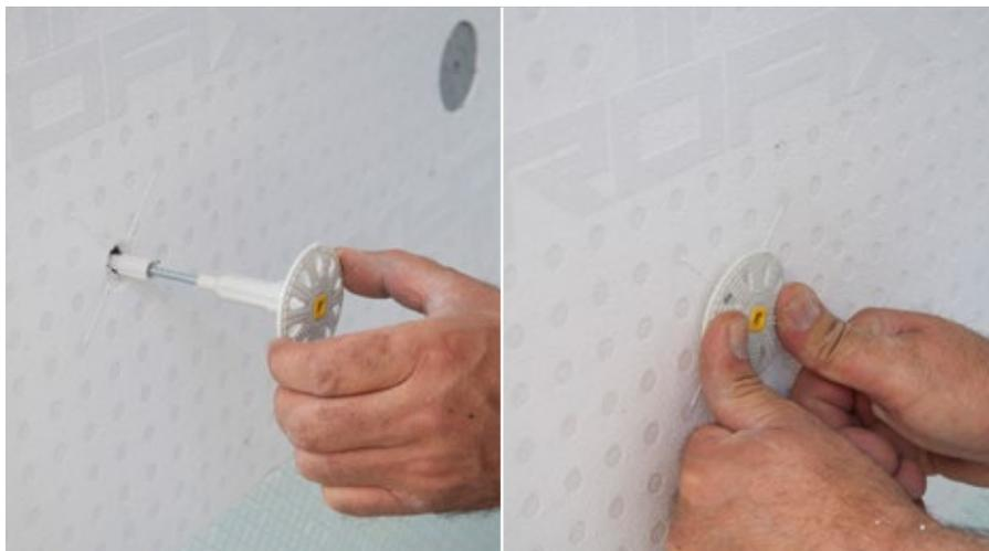
Montaggio a incasso: Inserire RÖFIX ROCKET nel foro. La testa del tassello deve essere posizionata a filo del pannello isolante.
