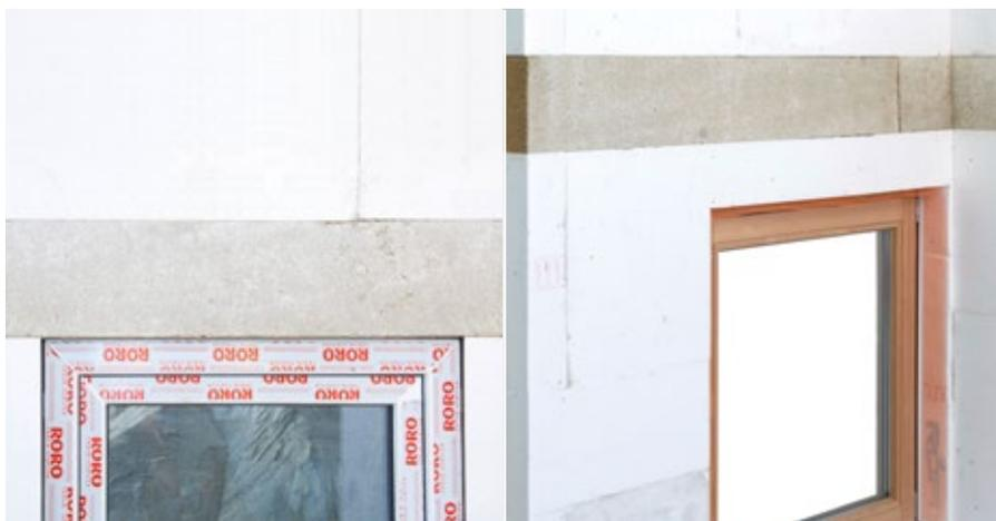
Disposizione sopra l'architrave delle finestre con una sporgenza laterale di 30 cm e un'altezza di 20 cm
