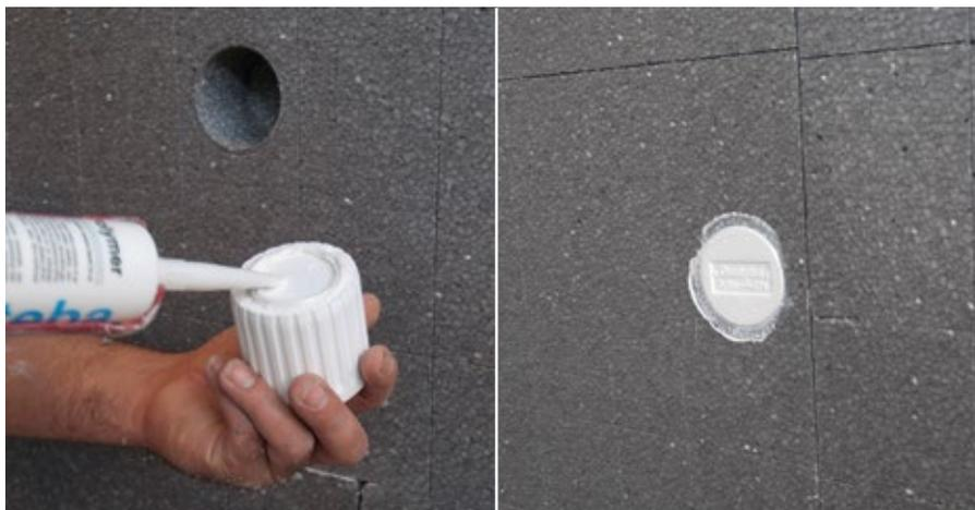
Applicare la colla PU sul retro di ZyRillo e sulle pareti laterali nel foro.
