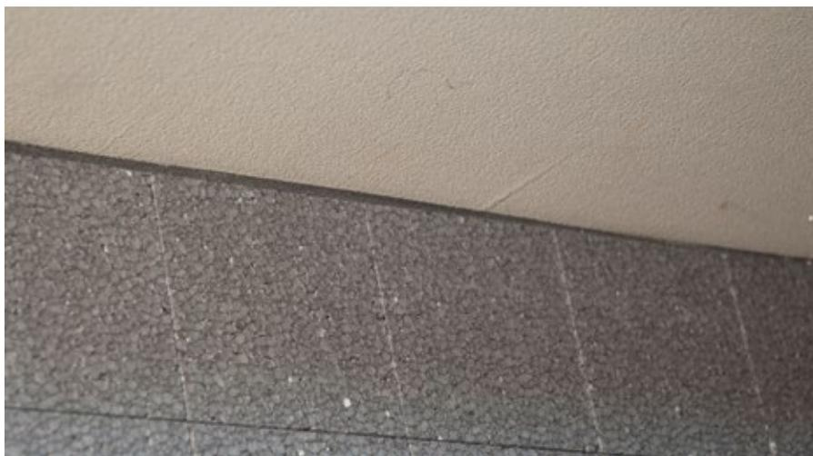
Durante l'incollaggio premere bene il pannello isolante della facciata contro il nastro di guarnizione in modo che venga compresso
