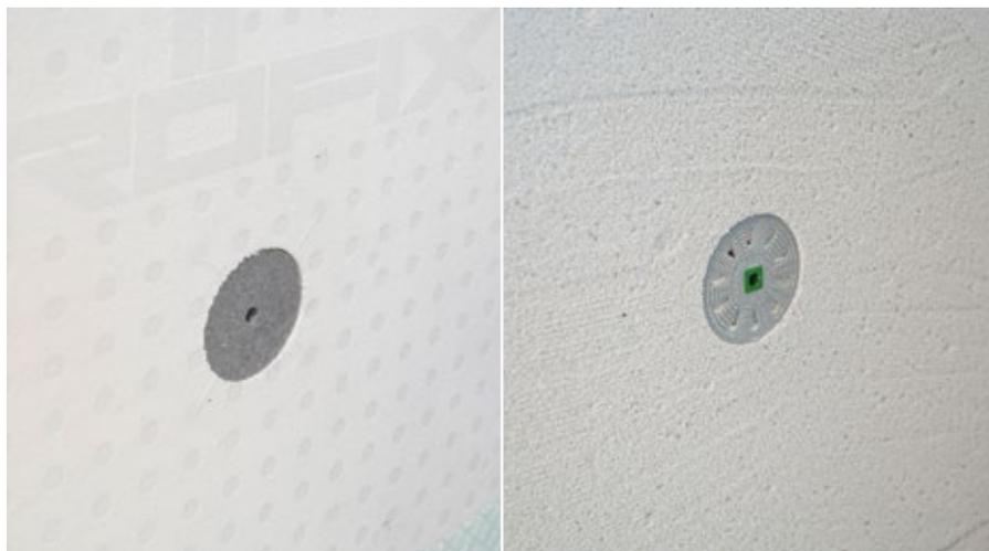
RÖFIX ROCKET montaggio a incasso con rondella di copertura in EPS.
