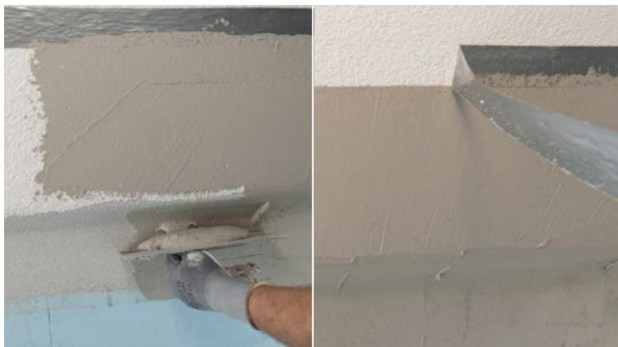
Impermeabilizzare la rasatura armata con rivestimento utilizzando RÖFIX OPTIFLEX®
