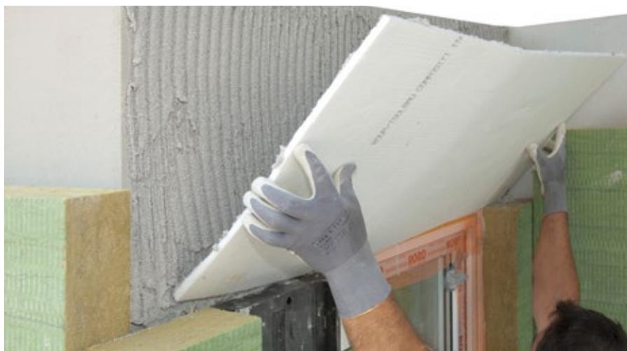
Incollaggio a superficie piena in metodo floating buttering del pannello RÖFIX Aerogel
