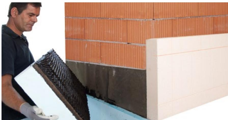
Incollare a superficie piena il pannello isolante per zoccolatura RÖFIX EPS-P sulla guaina bituminosa utilizzando RÖFIX Collstar
