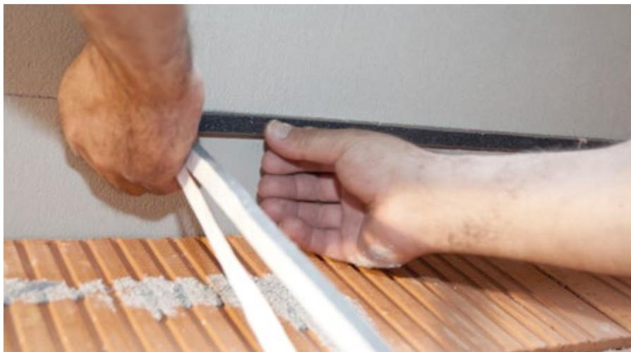
Incollare il nastro di guarnizione RÖFIX sulla parte sottostante del balcone o copertura
