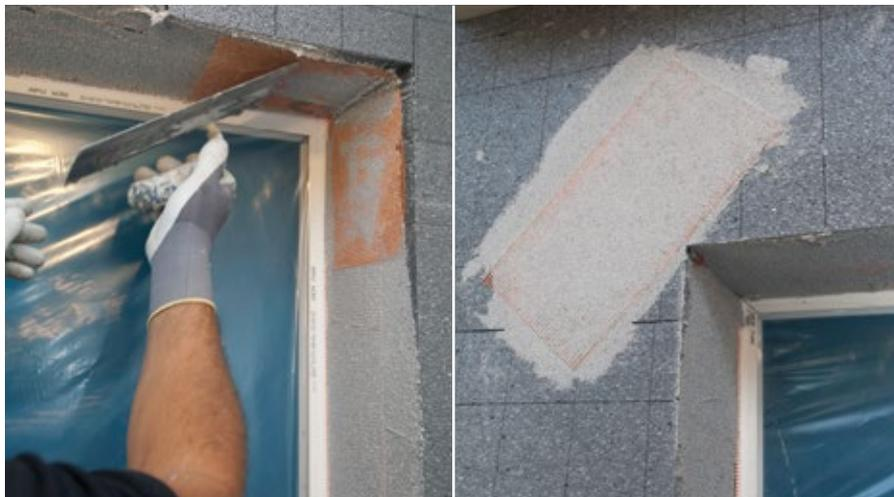
La rete di armatura RÖFIX P50 viene sempre annegata nel rasante fresco precedentemente steso sull'isolante.
