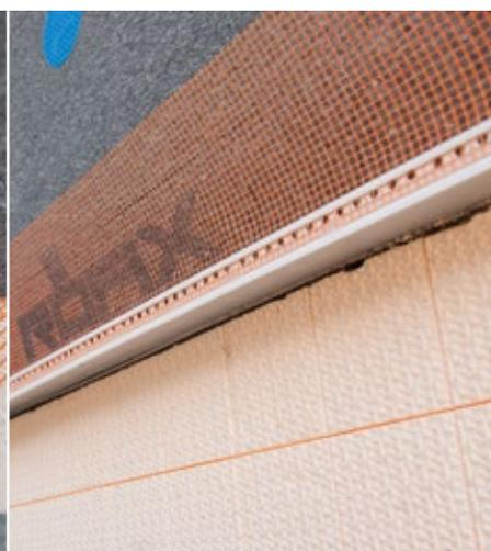
Profilo di chiusura della zoccolatura e montato accuratamente con gocciolatoio
