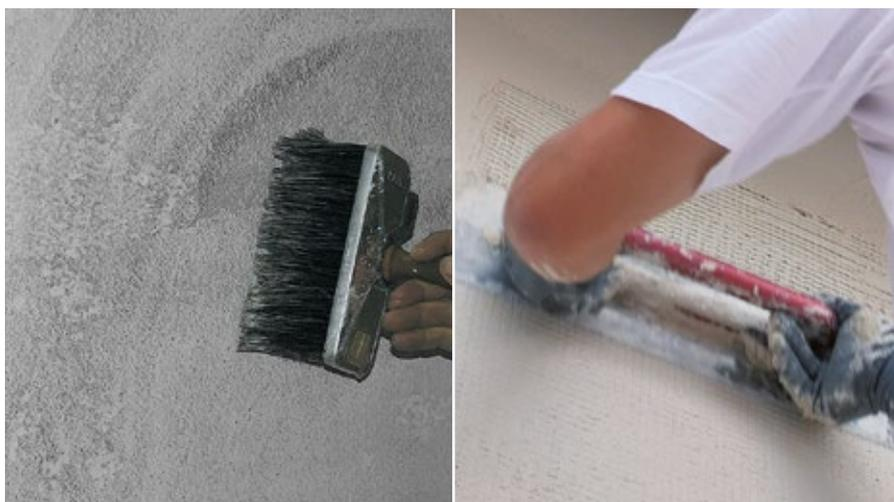
Fissaggio della superficie con RÖFIX PP 201
