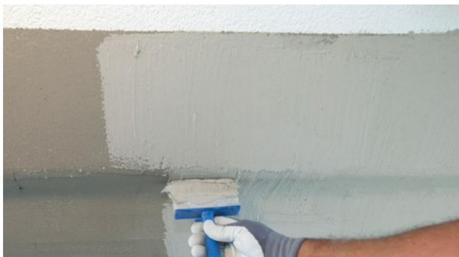
La seconda mano di strato impermeabilizzante può essere data anche a pennello utilizzando RÖFIX OPTIFLEX®
