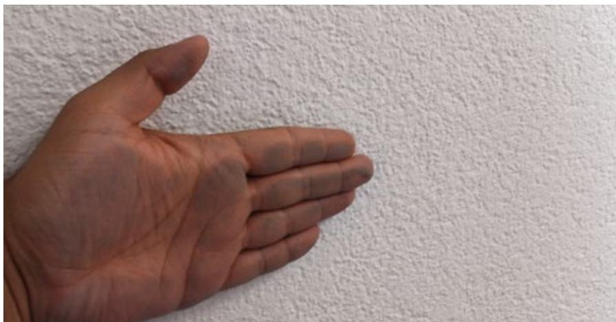
Rimuovere i supporti polverosi, gessosi e dare una mano di idoneo fissativo (RÖFIX PP 201 SILICA LF o RÖFIX PP 301 HYDRO LF opportunamente diluiti). Rimuovere meccanicamente le finiture a base calce
