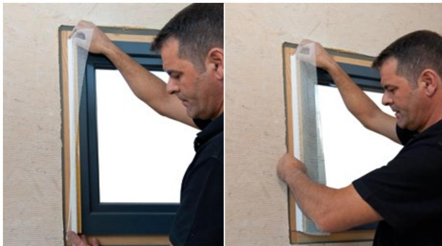
Posizionare il profilo ad angolo retto ed incollare sul telaio in legno sottostante
