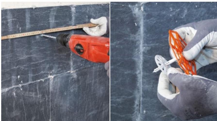
Posizionare i tasselli secondo un reticolo di 40x40 e montare secondo istruzioni contenute nell'imballaggio
