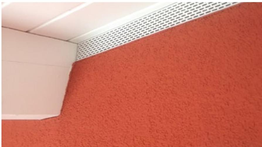
RÖFIX Profilo di raccordo a soffitto installato ed intonacato
