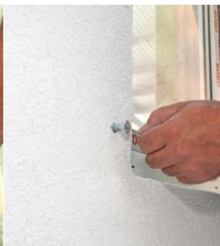
È possibile fissare l'elemento desiderato con una vite tipo M.
