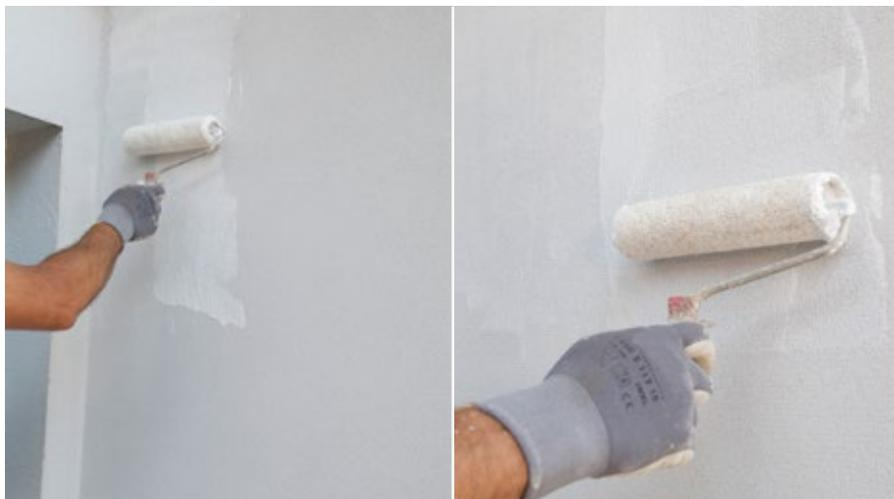
Con un rullo stendere in modo uniforme e coprente RÖFIX Primer PREMIUM e lasciarlo asciugare almeno 24 ore.
