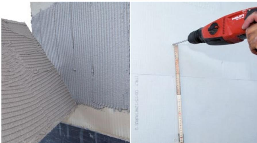
Posare il pannello isolante nel collante e unire senza collante le fughe
