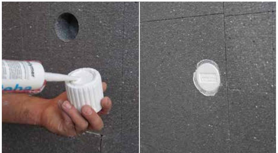
PU-Kleber auf die Rückseite des Zyrillos und auf die Seitenwände im Loch auftragen
