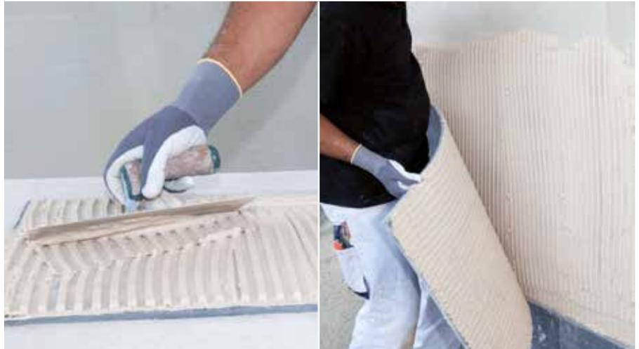
Kleber auf die Dämmmatte einmassieren sowie aufzählen und auch Kleber auf den Untergrund aufbringen und Dämmmatte anschliessend gut einschwimmen
