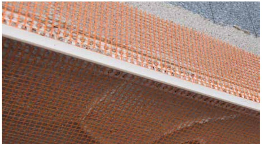
Vollflächig System- Klebe- und Armiermörtel vorlegen und das Tropfkantenprofil einbetten
