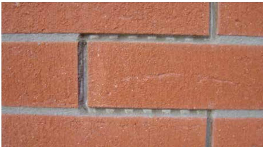
Belagsdehnfuge: Klebemörtel bis auf den Unterputz auskratzen, dann mit Sika- Primer 3N grundieren und mit Sikaflex Pro2HP verfugen
