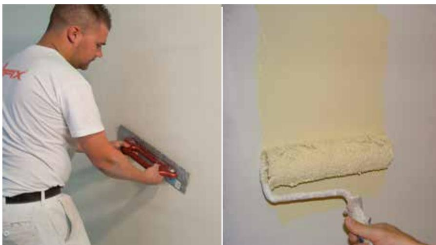
Auftragen des Deckputzes mit Stahltraufel
