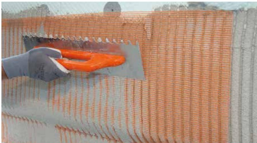
RÖFIX P50 Armierungsgewebe in den Systemklebe- und Armiermörtel einbetten
