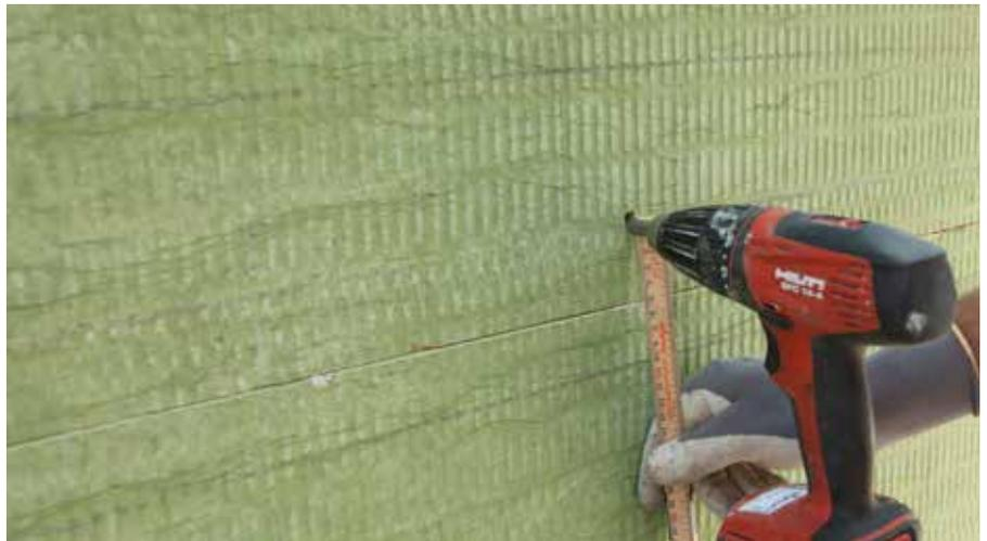
MW- Dämmplatten werden mit einem Abstand von 5 cm zur Dämmplattenaussenkante verdübelt
