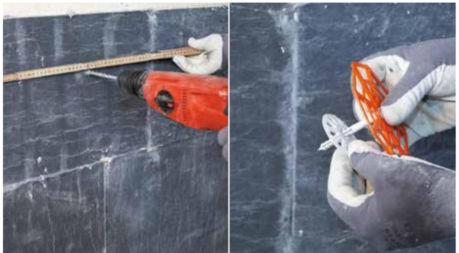
Die Dübel im Raster 40x40 cm anordnen und diese gemäss beigelegter Verpackungsanleitung montieren
