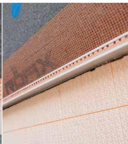
Fertig und dicht montiertes Sockelabschlussprofil mit Tropfkante vor dem Verputzen
