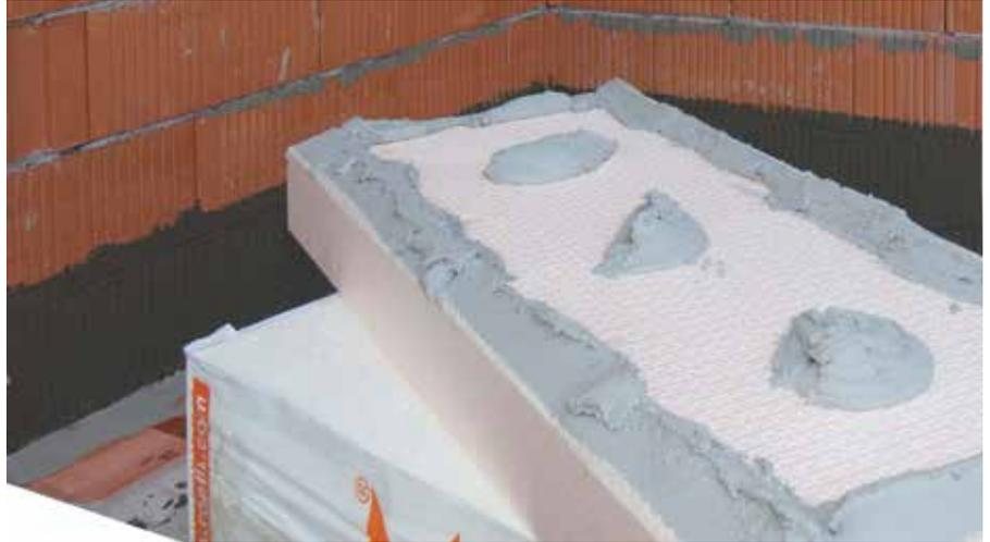
RÖFIX EPS-P 035 Sockeldämmplatte mit RÖFIX OPTIFLEX 1K oder 2K im Randwulst- Punkt Verfahren verkleben
