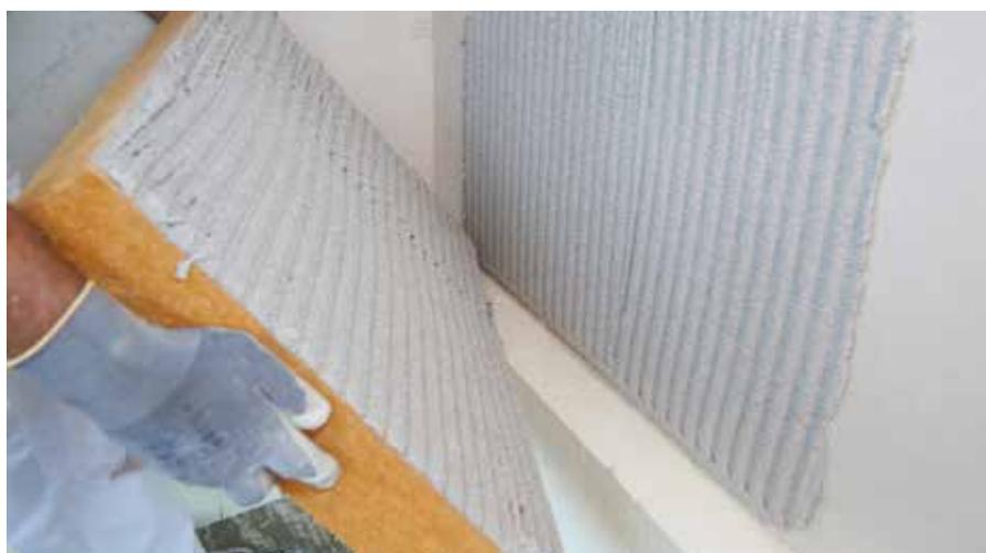
Dämmplatte verlegen und gut einschwimmen
