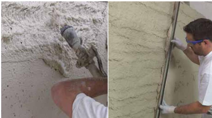
Auftragen und Abziehen des FIXIT 222 Aerogel-Hochleistungsdämmputzes
