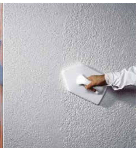
Nach ausreichender Trocknung des Unterputzes Oberputzvarianten auftragen und strukturieren
