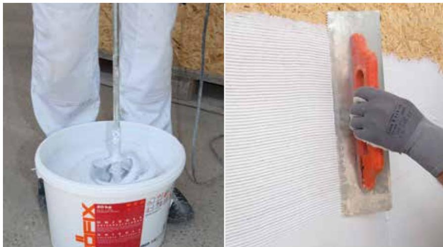
Den RÖFIX UNICOLL Universalkleber dünn-schichtig und vollflächig aufzuziehen und gut trocknen lassen
