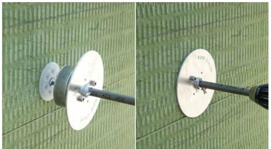
Mit dem RÖFIX STR- Tool 2G, den Dübel bis zum Anschlag versenken
