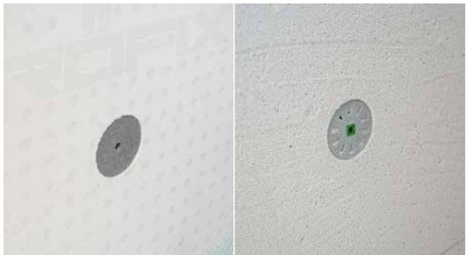
RÖFIX ROCKET versenkt montiert
