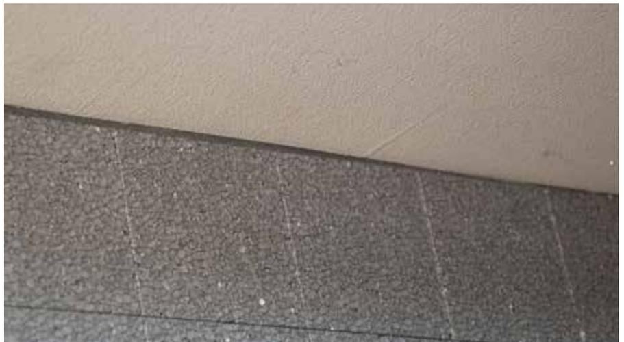
Die Fassadendämmplatte beim Verkleben gut gegen das Fugendichtband andrücken
