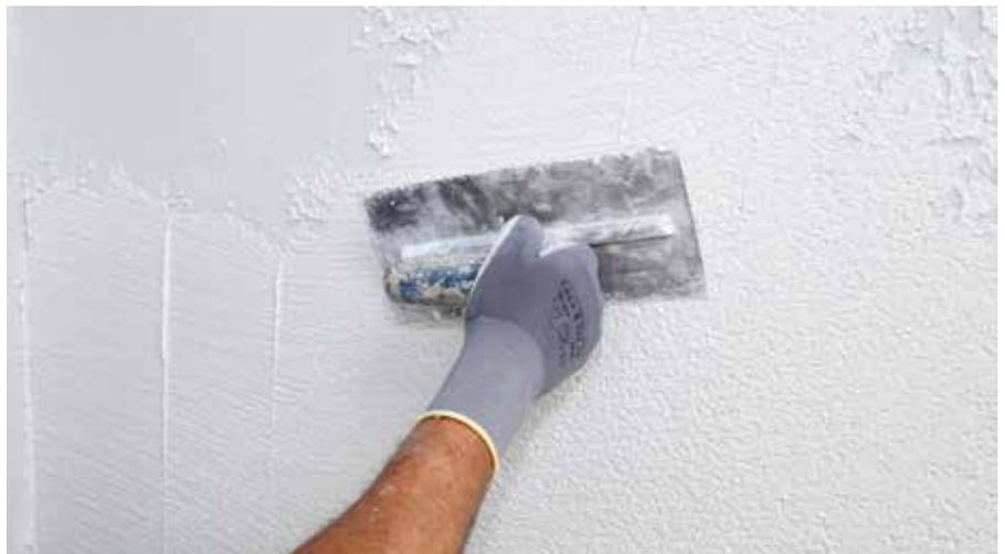
RÖFIX SiSi®-Putz weiss aufziehen und strukturieren
