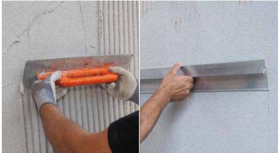
Unterputz aufziehen und in gleichmässigen Wulstbahnen aufkämmen. Anschliessend das RÖFIX P50 Armierungsgewebe einbetten. Mit der Talosche kann eine ebene Oberfläche abgezogen werden
