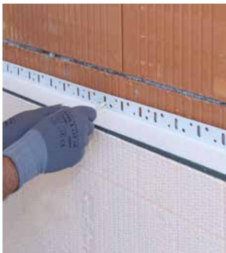
RÖFIX Sockelbasisprofil befestigen
