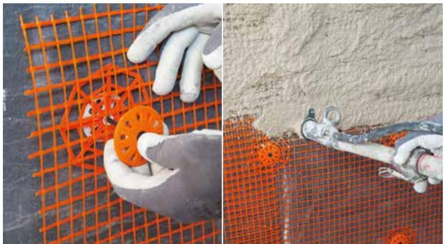
Das RÖFIX AR Stützgewebe mit dem RÖFIX BTH Mit mindestens 10 mm RÖFIX AeroCalce® IA 784 sowie dem RÖFIX NDF einhängen und befestigen PLUS verputzen
