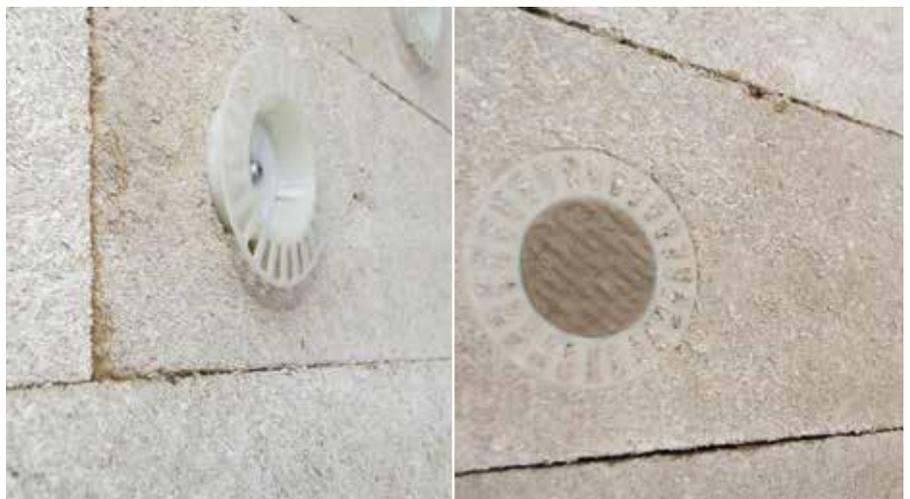
Mit dem RÖFIX VT2G- Versenksteller können Mineralwolle- Lamellendämmplatten problemlos versenkt gedübelt werden
