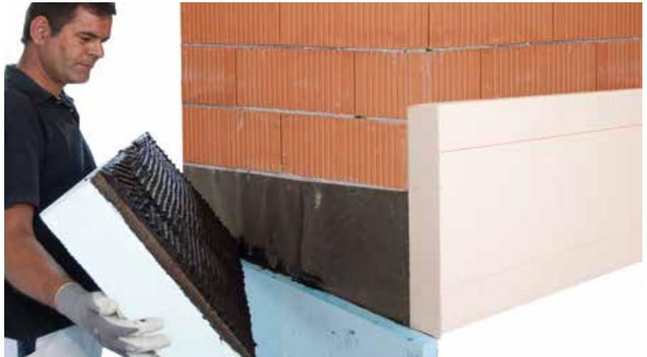
RÖFIX EPS-P 035 Sockeldämmplatte auf Bitumen mit RÖFIX 1K Plus vollflächig verkleben
