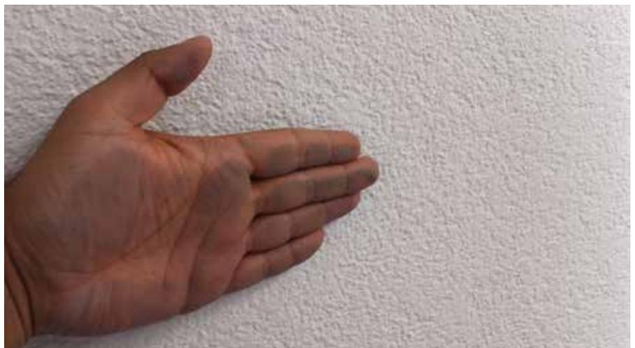
Staubige, kreadende Untergründe abkehren, mit verdünntem RÖFIX PP 201 SILICA LF Silikat-Tiefengrund grundieren. Kalkbeschichtungen mechanisch entfernen
