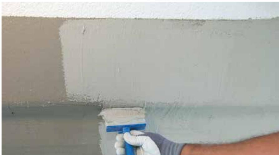
Als 2. Lage der Abdichtungsschicht kann RÖFIX OPTIFLEX® 1K oder 2K geschlänmt werden
