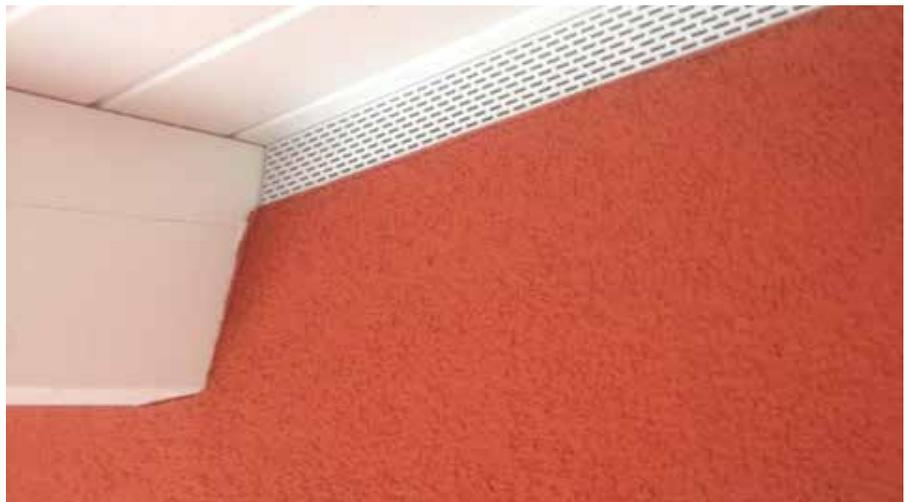
Fertig eingebautes und verputztes RÖFIX Dachabschlussprofil
