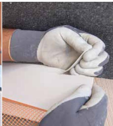
Je nach Dämmstoffdicke das RÖFIX Sockeleinschubprofil einstellen
