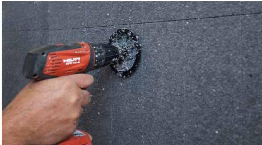
Do- Rondo Fräse bis zum Anschlag einfräsen
