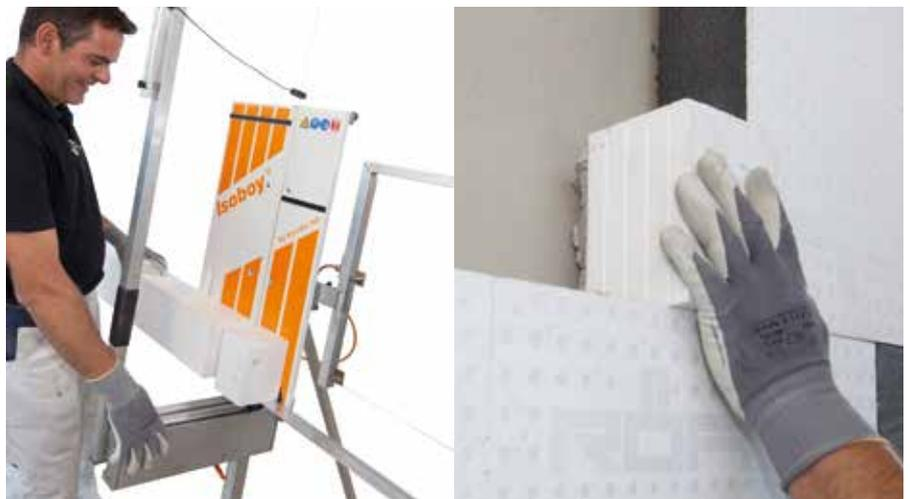
Das RÖFIX Quick-Quader EPS Montageelement mit RÖFIX ISOBOY GD 34 ablängen und mit dem System- Klebe- und Armierungsmörtel ankleben
