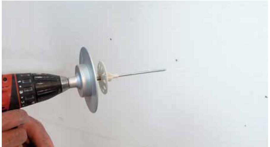
Dämmstoffteller RÖFIX ROCKET WOOD einschrauben
