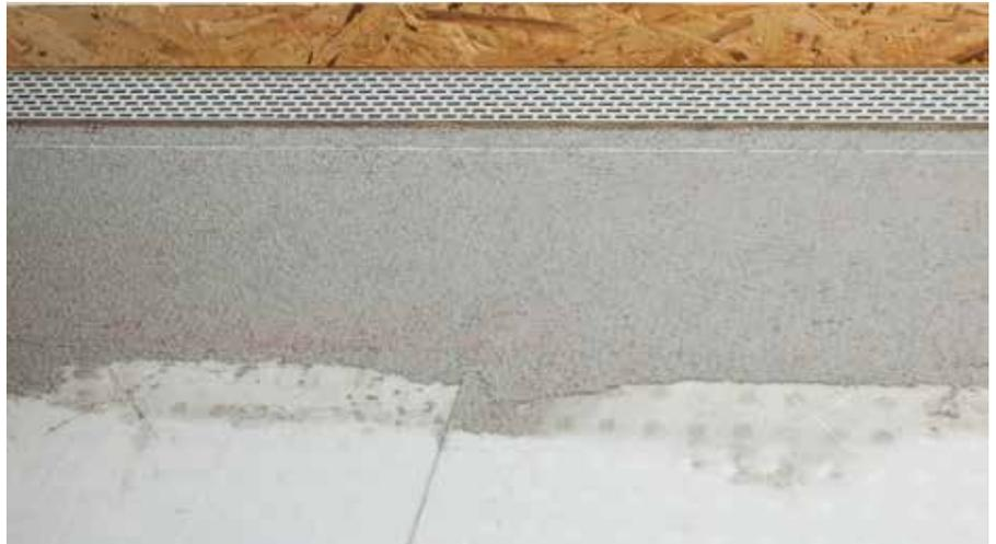
Das RÖFIX Dachabschlussprofil abkleben und in den vollflächig vorgelegten WDV-System Klebe- und Armierungsmörtel einbetten
