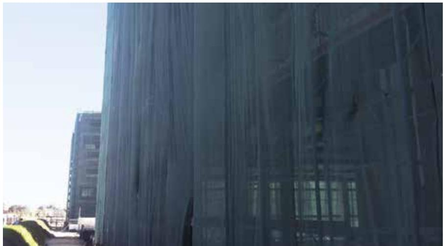
Fassadenschutznetz schützt frische Materialien vor externen Einwirkungen und zu schneller Austrocknung
