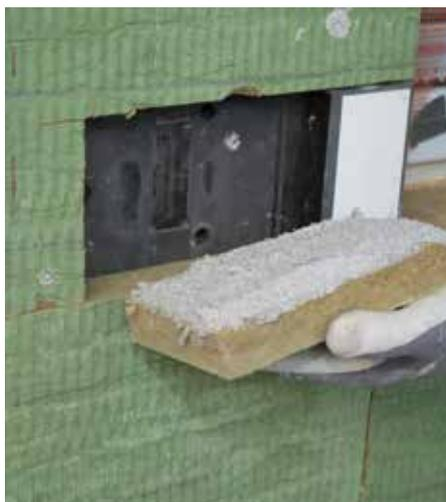
Dübel mit einer Dämmplatte abkleben/abdecken
