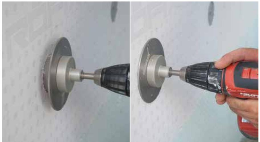
Das BIT gut in die Torx- Aufnahme einrasten, dann den Dübel „von selbst“ einziehen lassen (einschrauben ohne Druck auszuüben)
