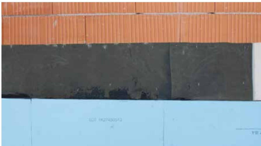
Mit RÖFIX 1K oder 2K Plus Kaltbitumenkleber auf Bitumenbahnen verklebte Sockeldämmplatten
