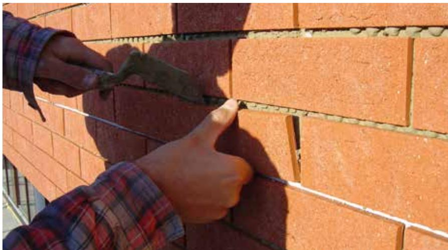
Klinker vollflächig in Floating & Buttering-Verfahren kleben
