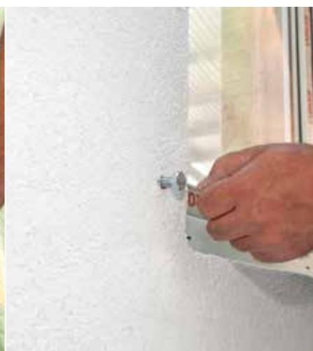
Mit einer M-Schraube kann das gewünschte Element befestigt werden
