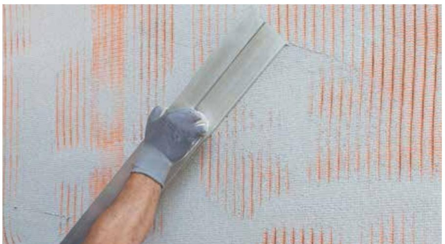
Das RÖFIX P50 Armierungsgewebe in den frisch aufgekämmten Unterputz einbetten
