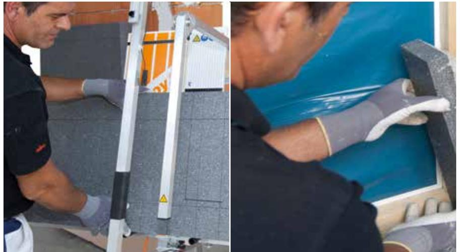
Stiefelschnitt und Dachsparren mit dem RÖFIX Isoboy EX 34-K Eckschneider schneiden
