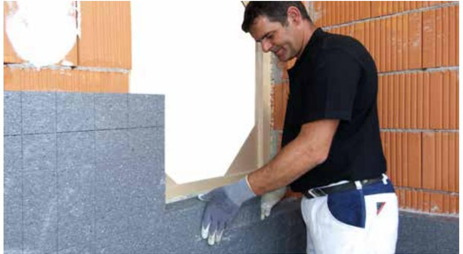
Bei Öffnungen die Dämmplatten mit Stiefelschnitt anbringen
