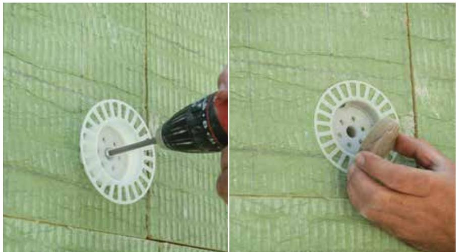
Vormontierten Dübel in gebohrtes Loch einschieben und einschrauben, dann mit der RÖFIX STR-Rondelle abdecken
