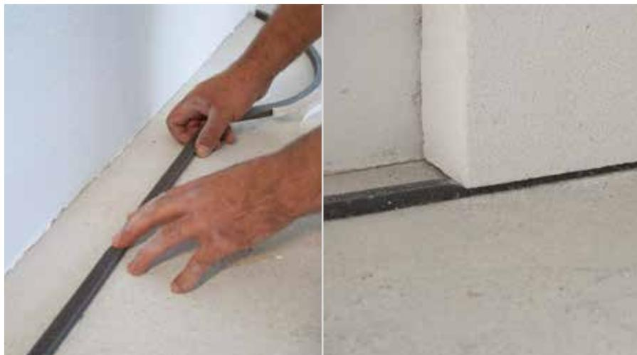
Innendämmsystem gegen den Boden, die Wand und die Decke mit RÖFIX Fugendichtband abschliessen
