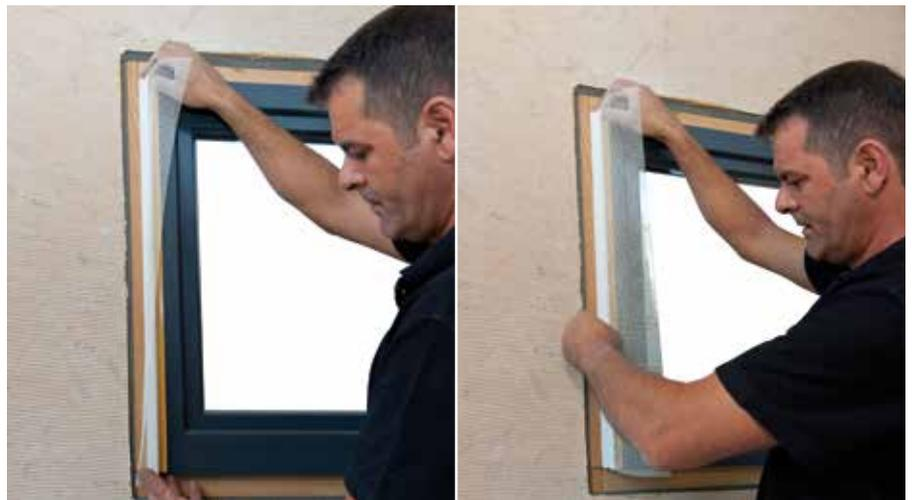
Das Profil im rechten Winkel am Alurahmen anschlagen und auf den darunterliegenden Holzrahmen aufkleben
