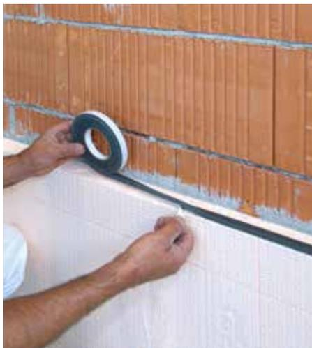
Fugendichtband auf die Sockelplatte aufkleben
