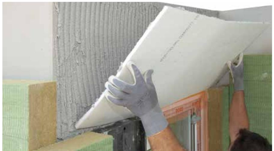
Die RÖFIX Aerogel- Dämmmatte im Floating-Buttering-Verfahren vollflächig aufkleben
