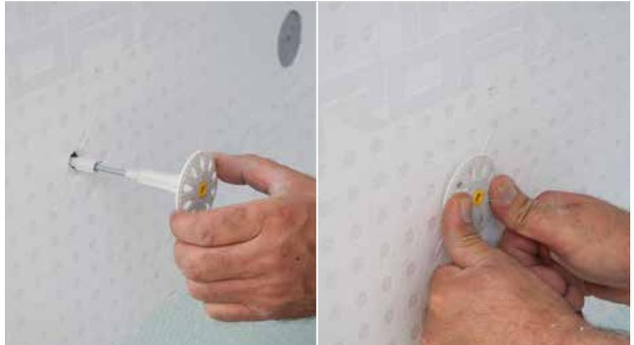
RÖFIX ROCKET bis zum Dübelteller, bündig mit den Dämmlatten, einschieben
