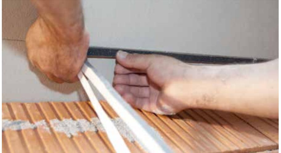
RÖFIX Fugendichtband auf die Balkonuntersicht aufkleben
