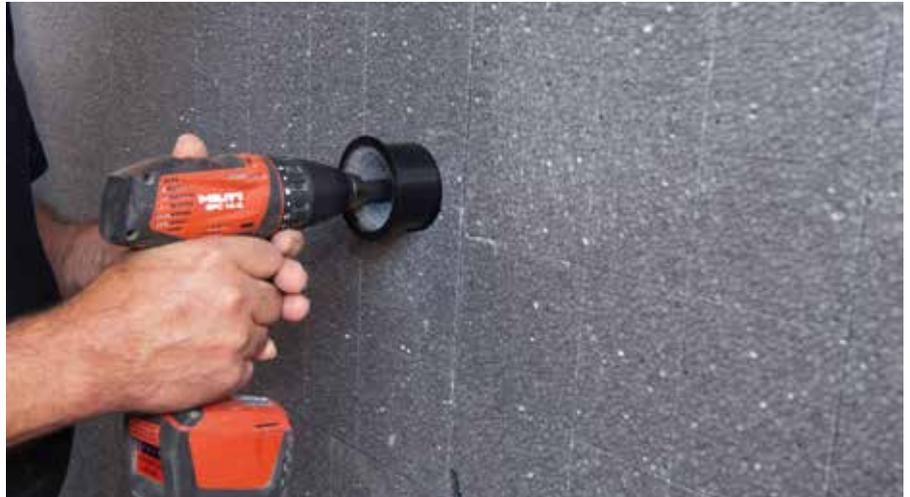
Mit der ZyRillo-Fräse bis zum Anschlag fräsen
