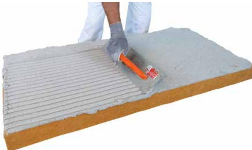
Beim Floating-Buttering-Verfahren wird Kleber vollflächig auf den Untergrund sowie auf die Dämmplatte aufgetragen
