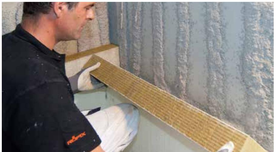
RÖFIX Speed-MW-Dämmplatten in den frisch aufgespritzten Kleberbahnen gut einschwimmen
