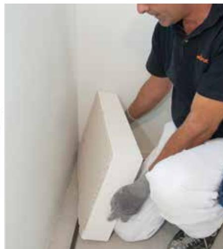
Beim Verlegen die Dämmplatte gut einschwimmen
