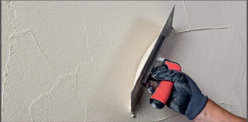
Die Oberfläche mit einem geeigneten Werkzeug (Bürste) bearbeiten und dabei den frisch aufgezogenen Oberputz quetschen/anpressen, um die gewünschte Maserung zu erzeugen.
