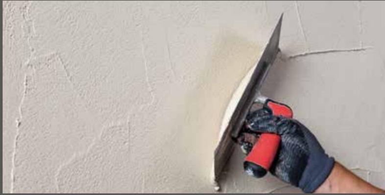
Mit einer Stahltraufel in den noch frischen Oberputz drücken und so Spitzen des frischen Putzmaterials an die Oberfläche ziehen.
