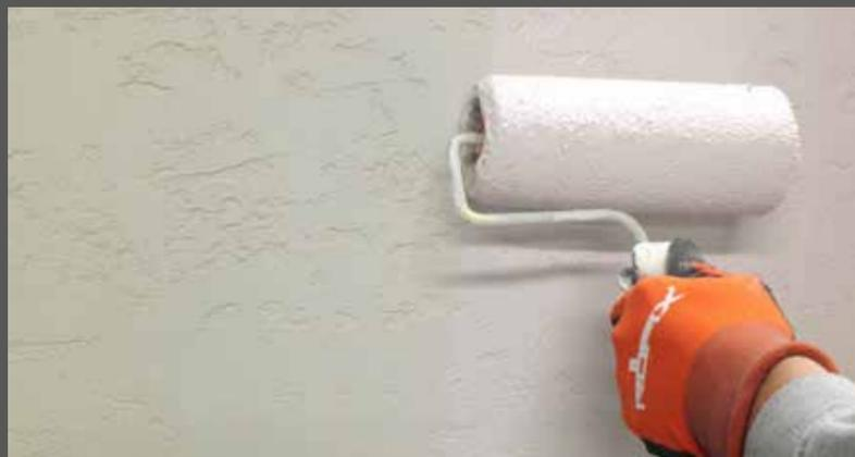
Nach Trocknung der Fassadenfarbe wird je nach gewünschtem Effekt die eingefärbte RÖFIX PP 403 MULTI Silikonharz-Lasur mit einem Handschuh, Pinsel oder Tuch verarbeitet.
